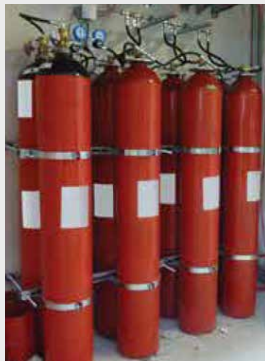
▼ Sistemi ad acqua nebulizzata Water Mist costituiti da gruppi con bombole di azoto e bombole di acqua
